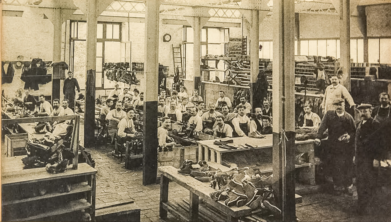
MANUFACTURE E. PACORY — Montage et finissage trépointe (salle n° 2)
