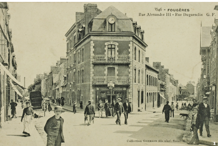
1 - Rue Alexandre III et rue Duguesclin - Fougères
